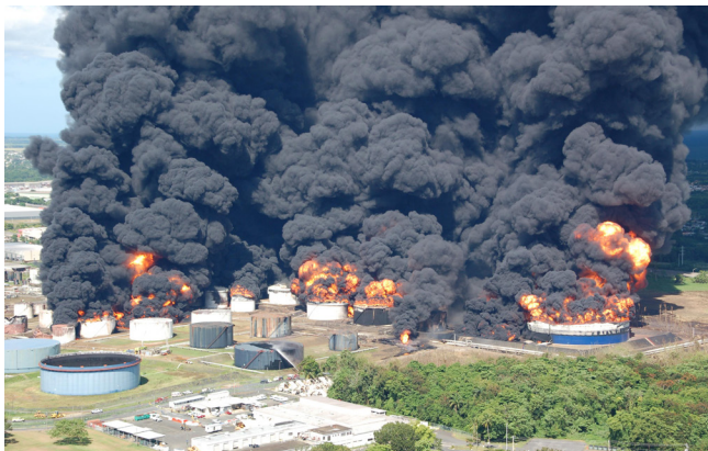
Рис. 38 — Авария на пожаровзрывоопасном объекте
